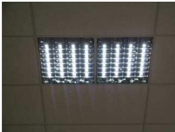
Длительный срок жизни светодиодных источников света (до 10 лет), их стойкость к механическим воздействиям и нестабильности напряжения в питающей сети, устойчивость к воздействиям окружающей среды (диапазон рабочих температур от -40 до +70°C, степень защиты IP 54 и IP 68) позволят сократить эксплуатационные расходы до 15 раз по сравнению с известными традиционными источниками света.
